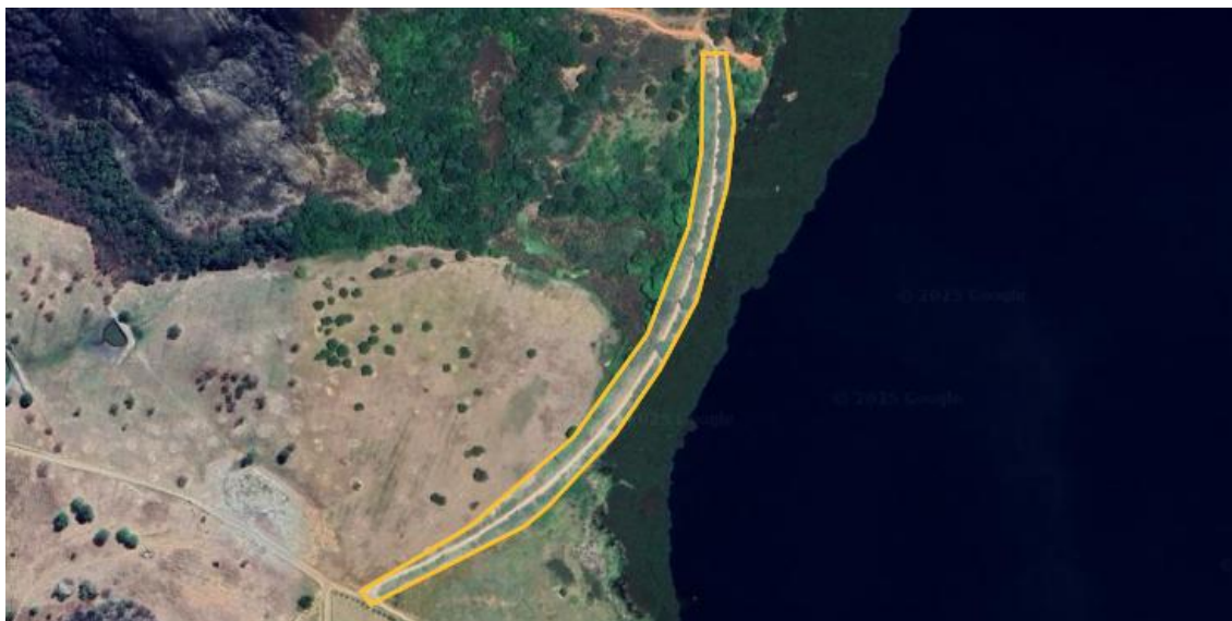
Figura 6 – Vista superior do dique 6 de Poço do Magro com indicação da área a ser realizada limpeza de vegetação: talude de montante, crista, talude de jusante, região a jusante.
