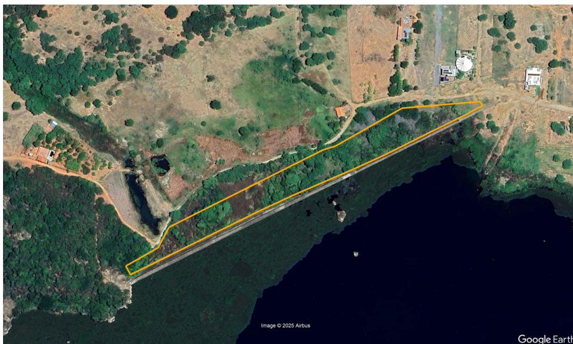
Figura 5 – Vista superior da Poço do Magro com indicação da área a ser realizada limpeza de vegetação: região a jusante e ombreiras.
