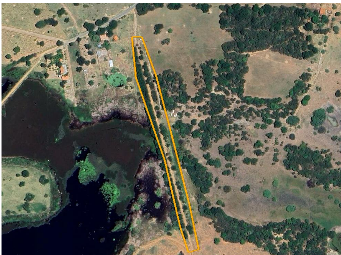
Figura 7 – Vista superior do dique 1 de Poço do Magro com indicação da área a ser realizada limpeza de vegetação: talude de montante, crista, talude de jusante, região a jusante.
