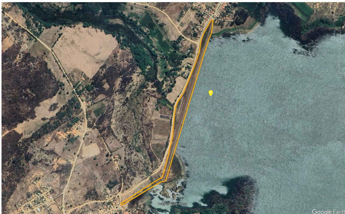
Figura 2 – Vista superior da Barragem Estreito com indicação da área a ser realizada limpeza de vegetação: talude de montante, crista, talude de jusante, região a jusante e parte do canal de aproximação/restituição demarcada.
