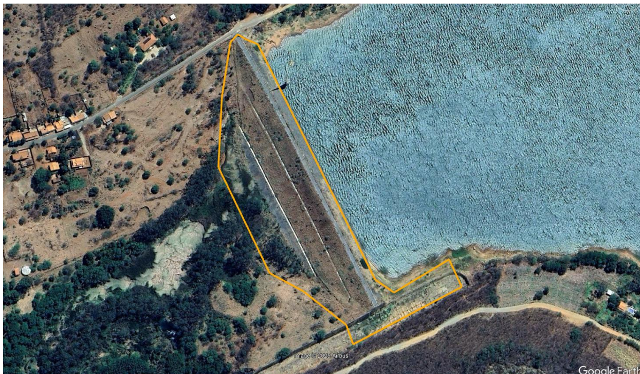
Figura 4 – Vista superior da Barragem Ceraíma com indicação da área a ser realizada limpeza de vegetação: talude de montante, crista, talude de jusante, região a jusante e parte do canal de aproximação/restituição demarcada.
