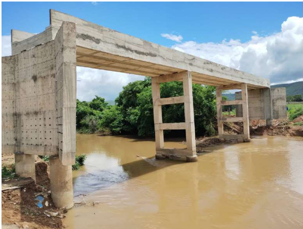
Figura 3– Vista Geral da Ponte construída sobre o Rio São Domingos
