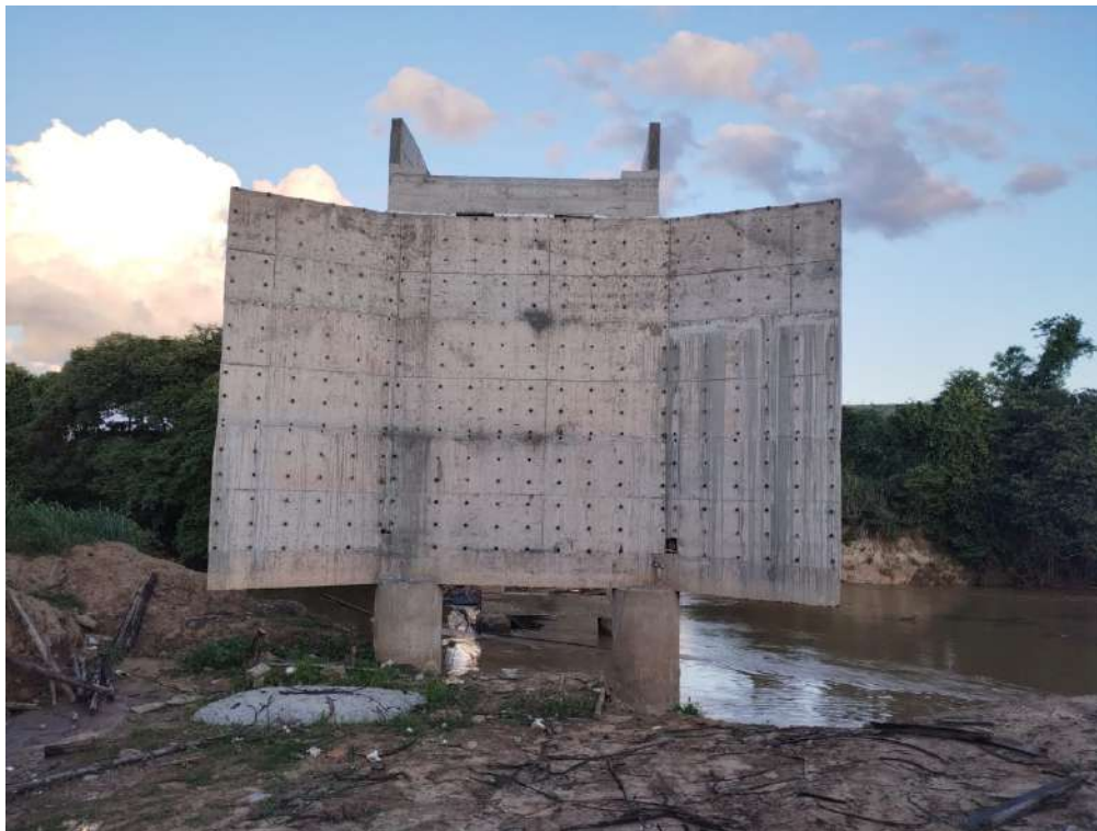
Figura 4 – Vista Geral da Ponte Cortina de Contenção Construída
