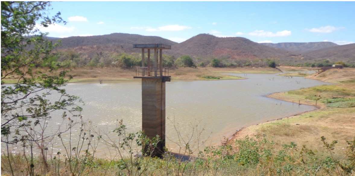
Figura 2 – Vista Geral da Tomada D'Água (Foto: 2020)
